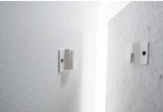
Wandmontage mit Aufhängeprofil
