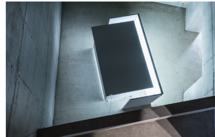
Sonderbau. Ausführung mit 4-Kantprofilen in den Ecken
