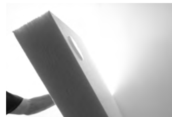
Montage mit Montagekleber
